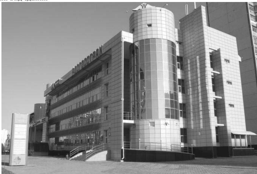
Рис. 11.1 Общий вид здания
